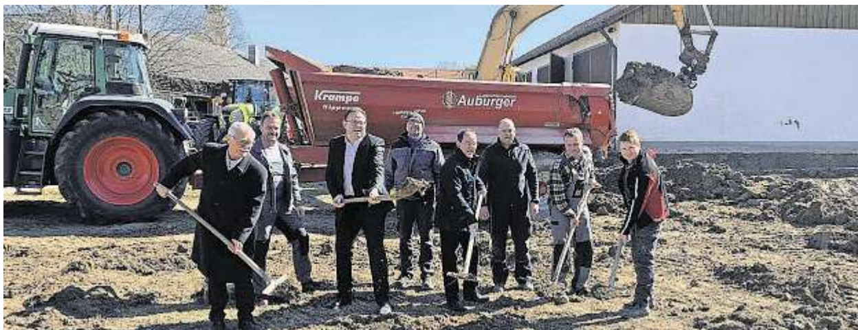
Nach dem Spatenstich (im Bild) wurde sofort die Baugrube ausgehoben.
