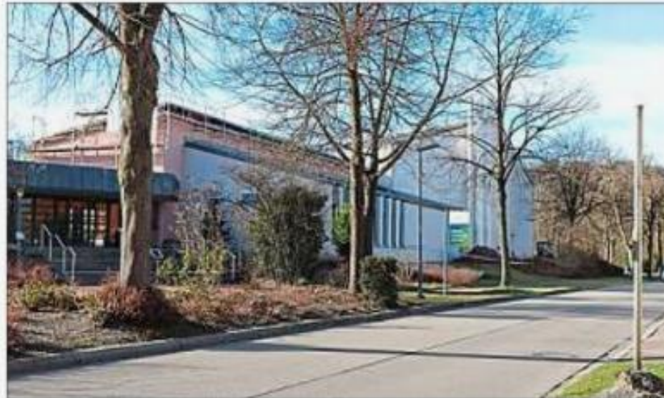
Das Bad Abbacher Kurhaus soll eine neue Heizanlage bekommen.
